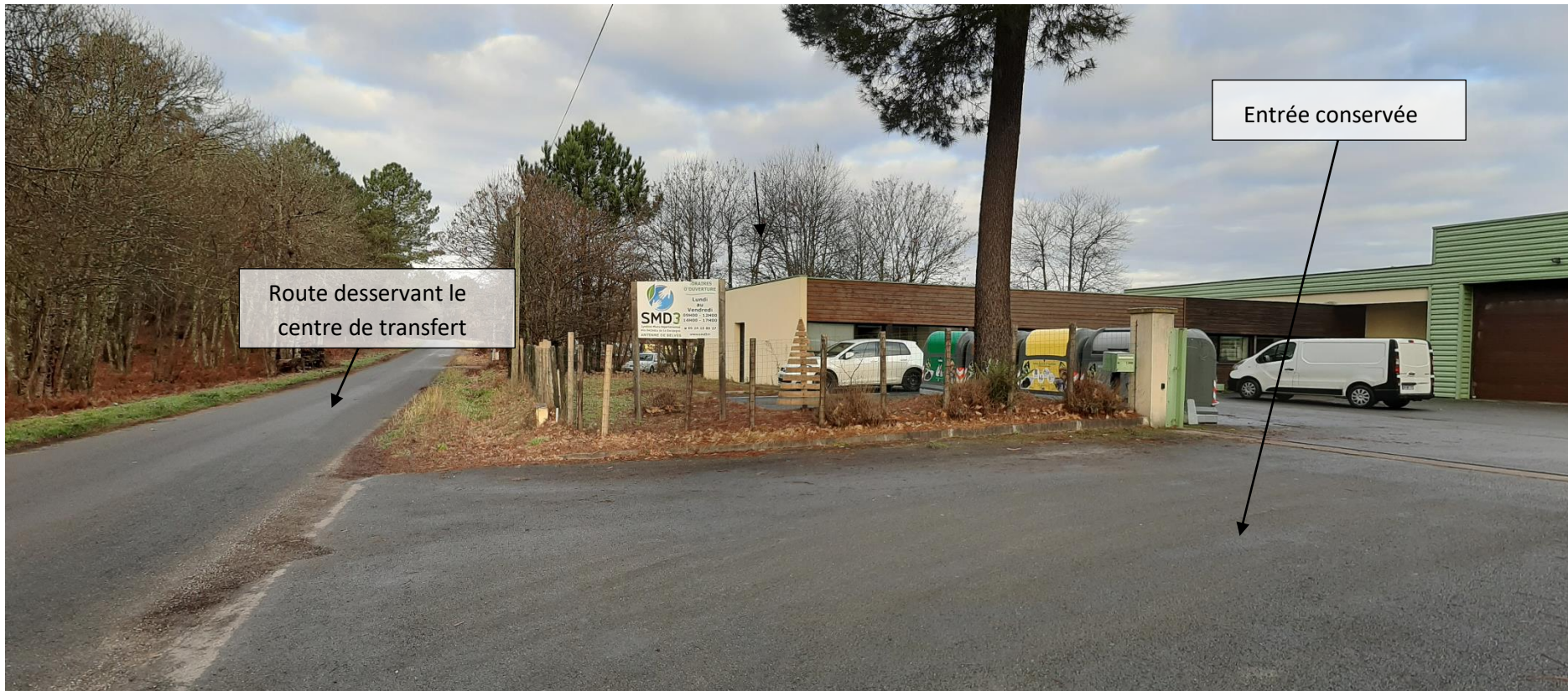
Figure 18 : Photo 1 – Antenne du SMD3 sur la commune de Pays de Belvès
